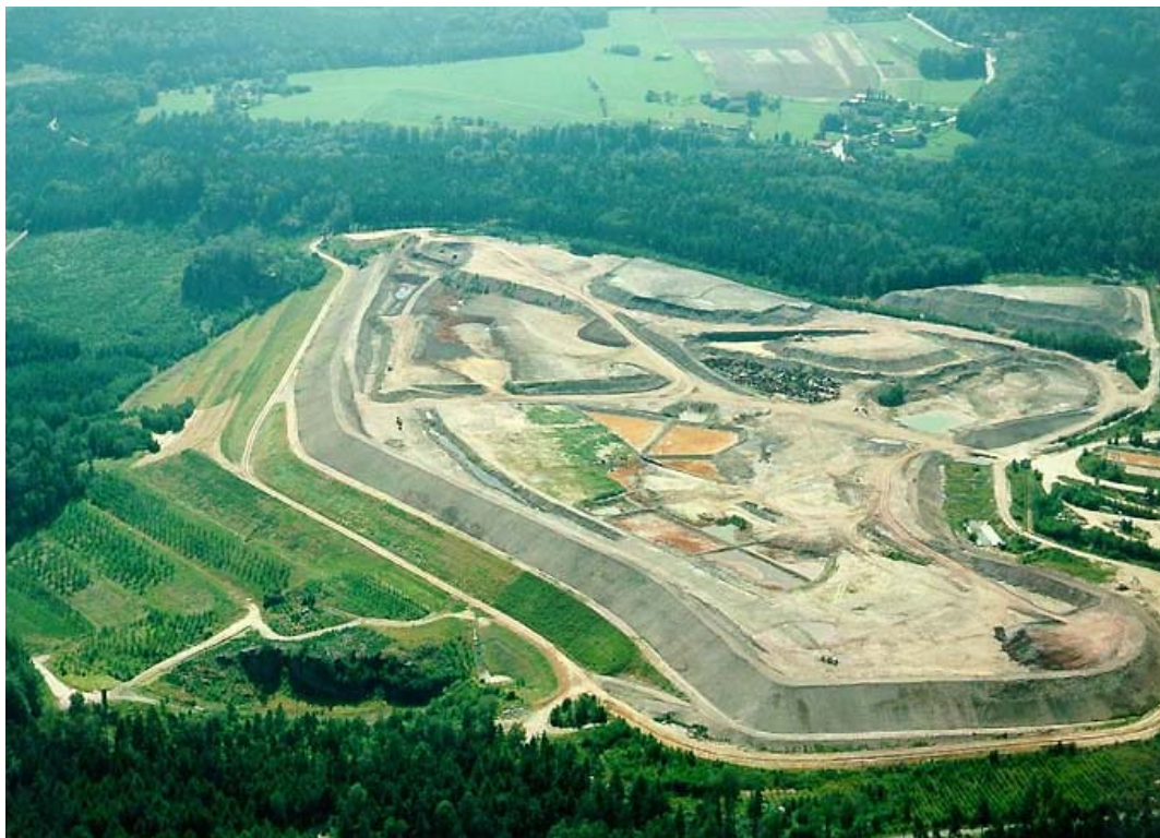
Abb. 2 Tafelhalde Schüsselgrund (3,7 Mio. m 3 ; 24,2 ha) am Sanierungsstandort Königstein als Talaufschüttung im Landschaftsschutzgebiet „Sächsische Schweiz“ auf Kreidesandsteinschichten mit begrünem Böschungsbereich (links vorn), Trockenbeeten für Schlämme der Wasserbehandlung (Mitte) und der Ortschaft Leupoldishain (hinten); L 273/50, © WISMUT GmbH 1993
