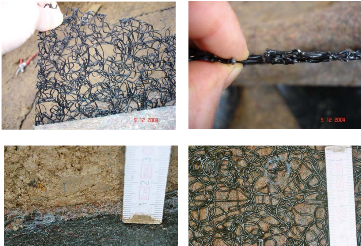
Bild 7 Dicke der Dränmatte und Flächendeckung des Dränkörpers
