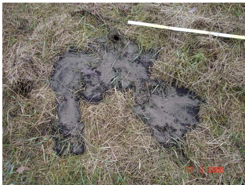
Bild 9 Bodenauswaschung nach Ausströmen von Druckwasser entlang eines Maulwurfganges am Böschungsfuß
