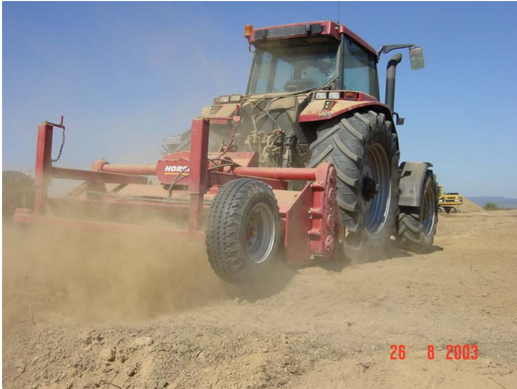
Foto 18 Fräsen von grobstückigem Unterboden aus der alten Abdeckung (UB-A1)
