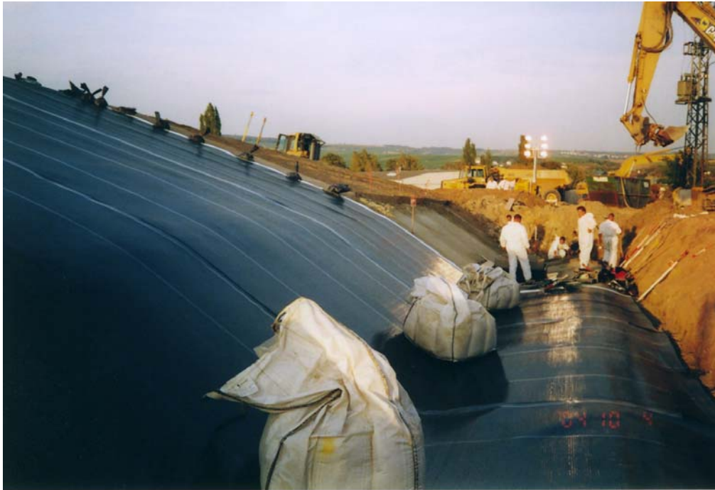
Foto 14 Riegelfixierung der Kunststoffdichtungsbahnen zur Erzielung der Planlage
