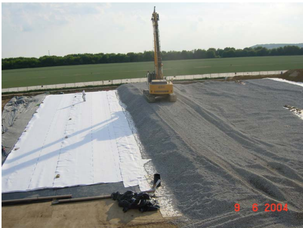
Foto 17 Einbau Kies 16/32 mit Langarmbagger auf Fahrdamm Entwässerungsschicht
