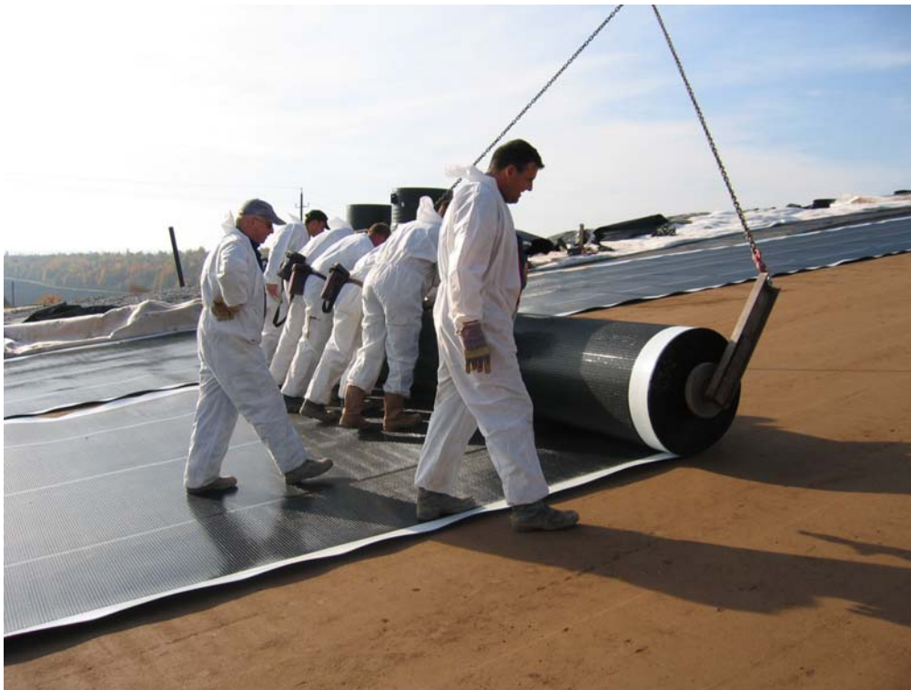
Foto 13 Verlegung der Kunststoffdichtungsbahnen auf dem freigegebenen Dichtungsaufleger
