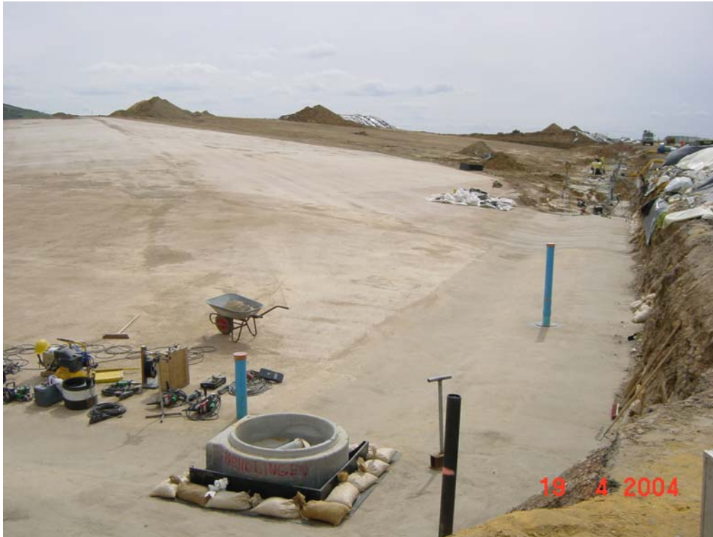
Foto 12 Fertiges Dichtungsaufleger Fläche und Randabschluss im Nordwesten
