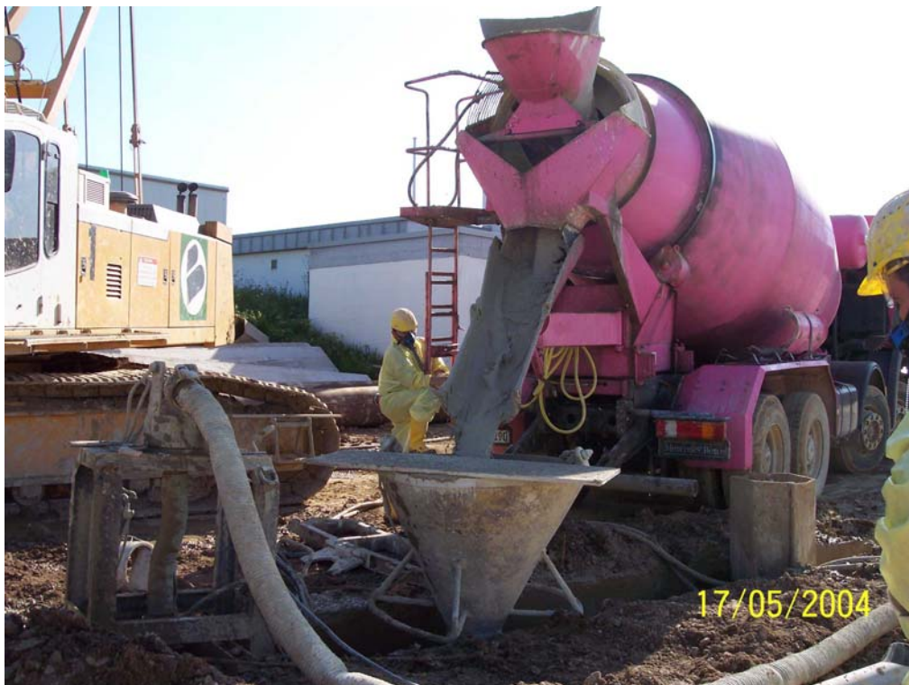
Foto 11 Einbau des Erdbetons mit Schüttrohren (Dichtwandbau)
