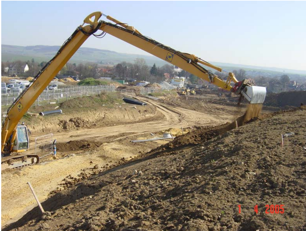
Foto 20 Einbau Oberboden mit Langarmbagger
