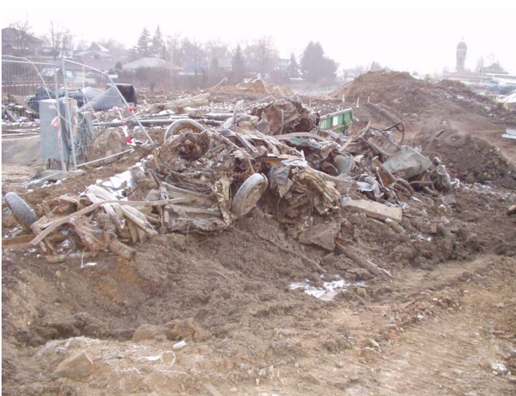
Foto 3 Störstoffe (Maßnahme B4)
