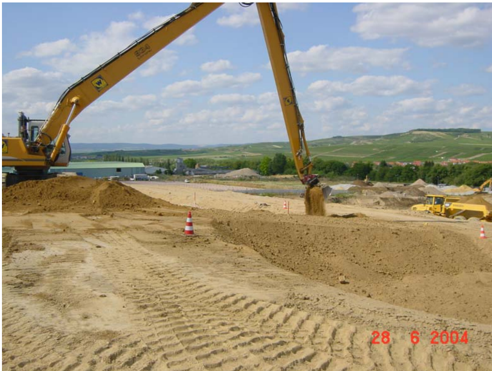
Foto 19 Einbau Unterboden mit Langarmbagger (von temporärer Baustraße)
