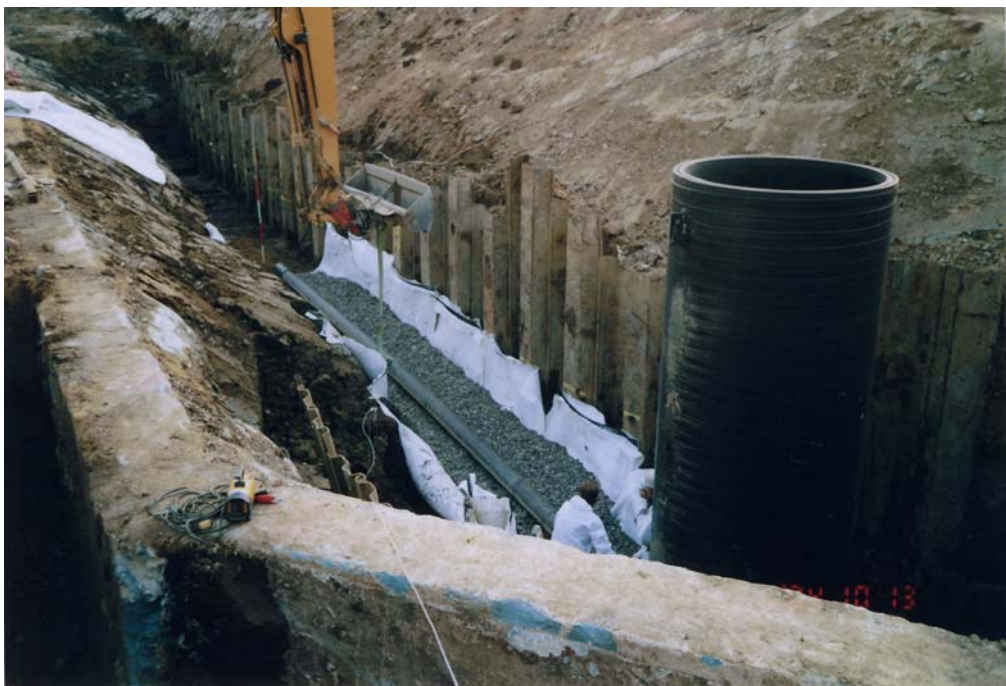
Foto 15 Rohrleitungsbau im Bereich des Abfallkörpers
