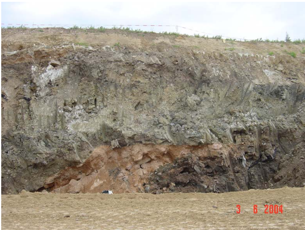
Foto 2 Wiederverfüllung (vorn) und Anschnitt Rückbaumassen (Maßnahme B4)
