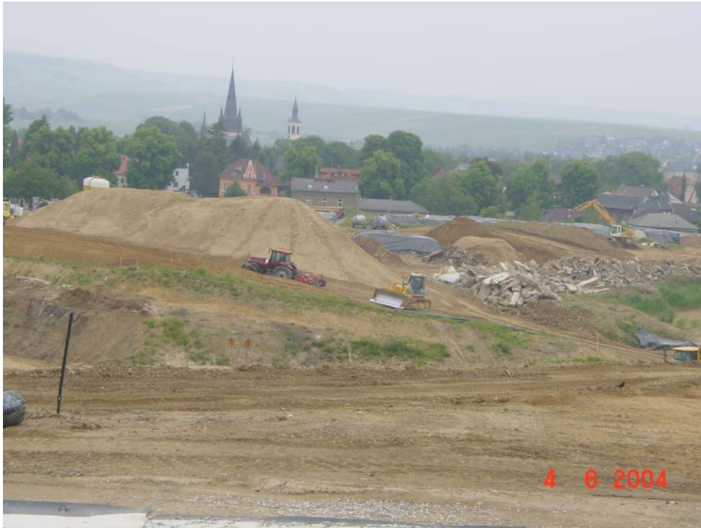
Foto 3 Separierung der rückgebauten Böden
