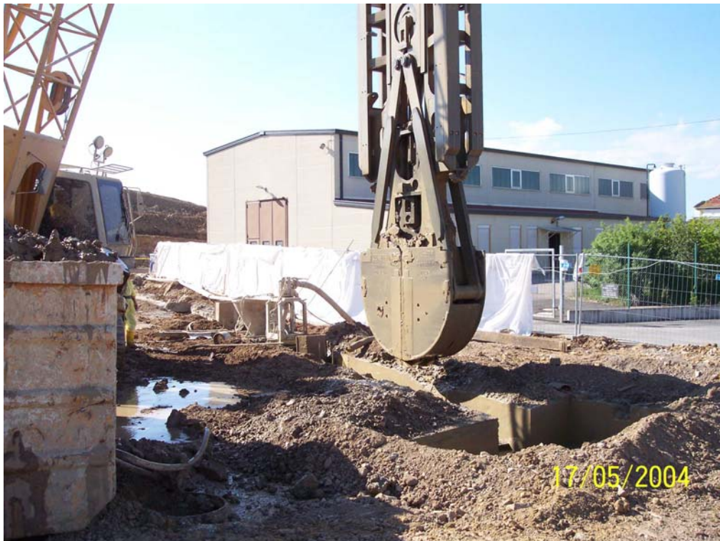
Foto 10 Schlitzwandgreifer beim Aushub einer Ecklamelle (Dichtwandbau)
