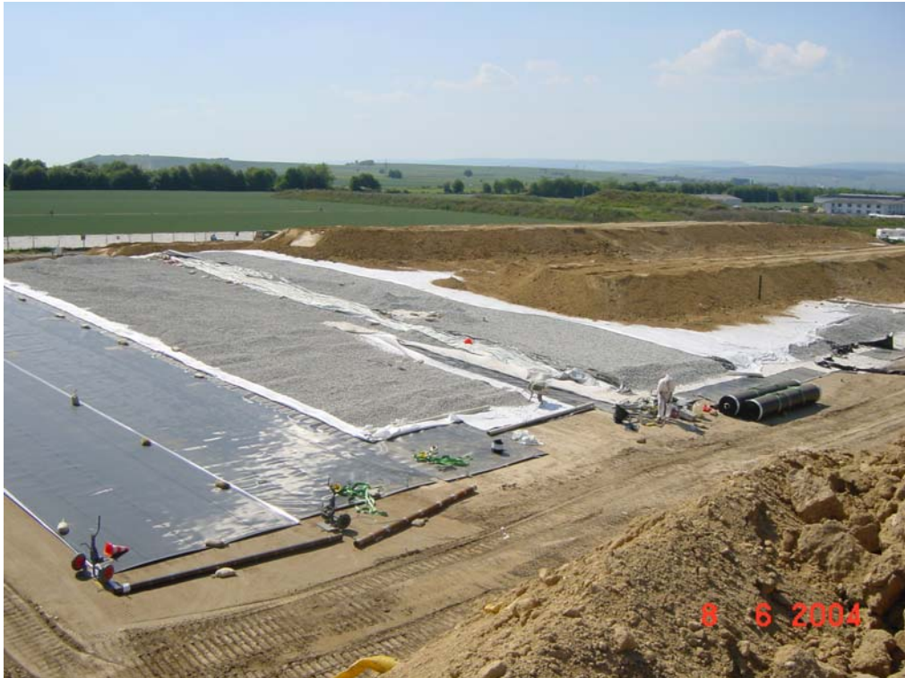
Foto 16 Neue Oberflächenabdichtung (von links: Dichtungsaufleger, KDB, geotextile Schutzlage, Entwässerungsschicht, geotextiler Flächenfilter, Baustraßen aus Unterboden)
