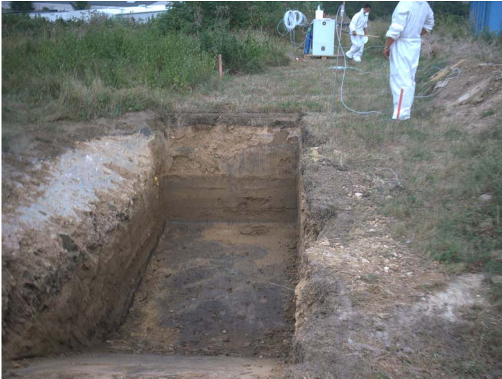
Foto 1 Schurferkundung der alten Oberflächenabdichtung bei der Flächenräumung
