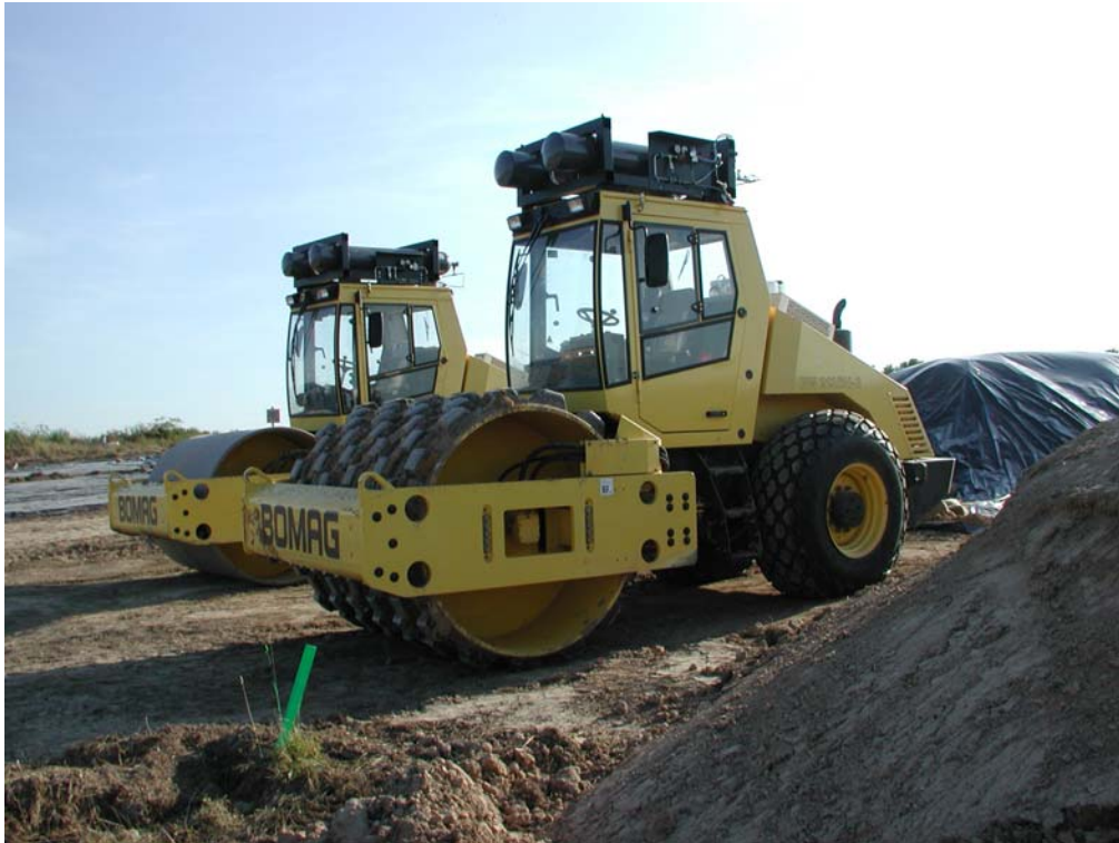
Foto 5 gekapselte (außenluftunabhängige) Baugeräte
